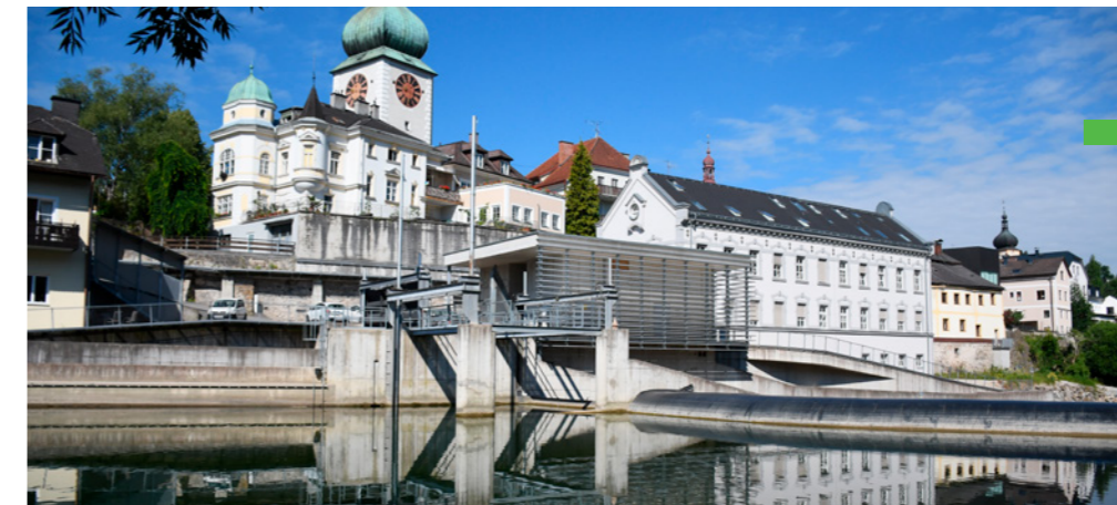
SHP Waidhofen, Autriche – un exemple d'intégration harmonieuse de la centrale hydroélectrique dans l'architecture urbaine.
