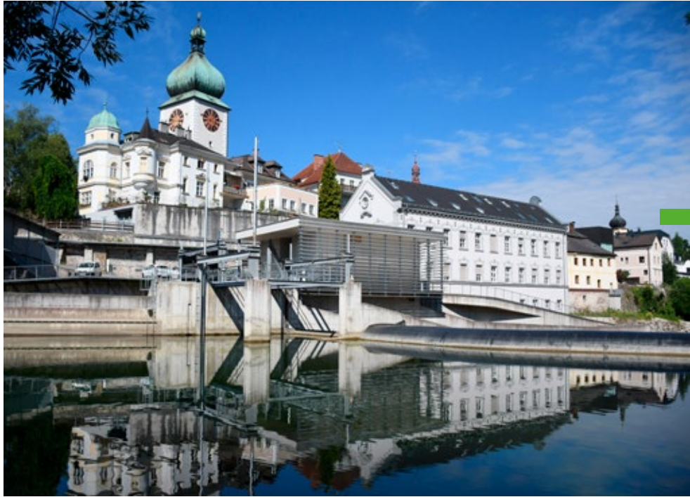
SHP Waidhofen, Österreich – ein Beispiel für die harmonische Integration des Wasserkraftwerks in die städtische Architektur.
