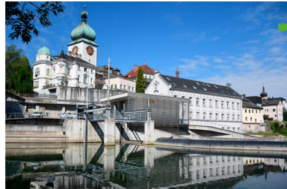
SHP Waidhofen, Austria – un esempio di integrazione armoniosa della centrale idroelettrica con l'architettura urbana.
